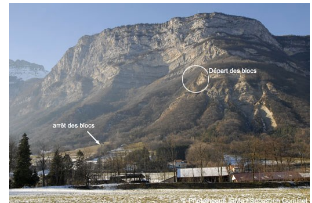
Risque de chute de blocs à Saint-Paul-de-Varces
