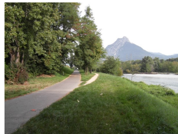
Digues du Drac
